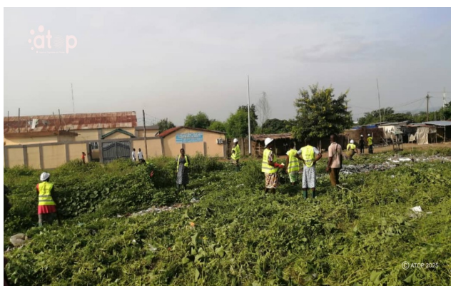
Vue partielle de l'opération à Atakpamé
